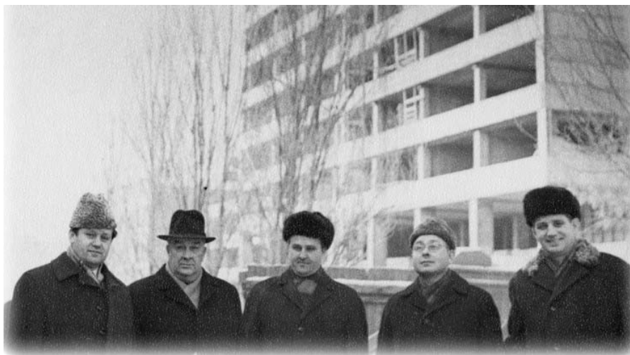
Строительство главного корпуса ДонГУ
