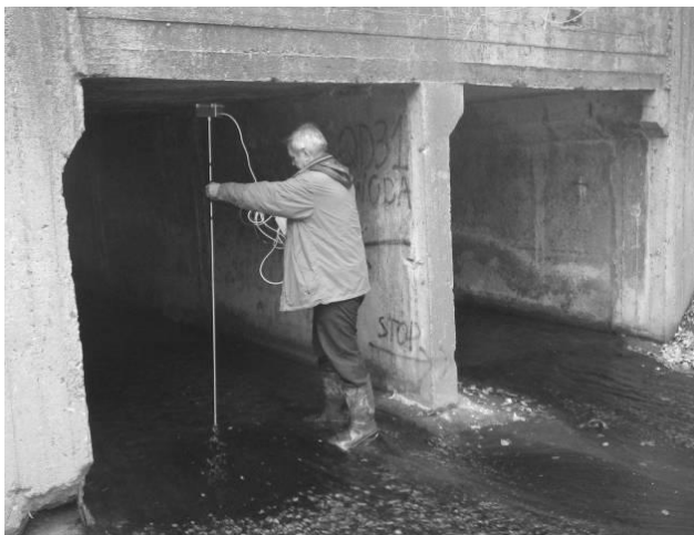
Рис. 3. Измерение скорости потока на выходе галерей водосбросового сооружения Третьего городского пруда
