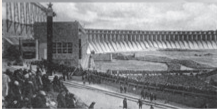
Днепровская ГЭС им. В.И. Ленина. 1932 г.
