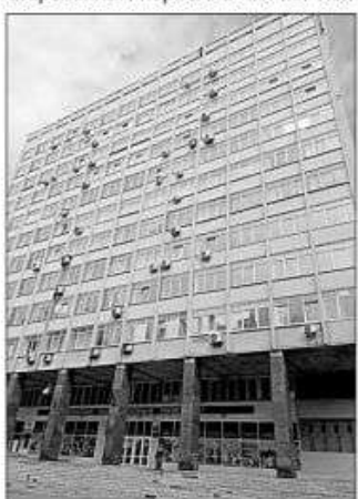
Ремонт в главном корпусе вуза в приоритете
